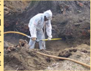
Using Air Spade.
